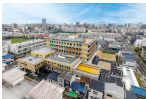
外観北西面全景
